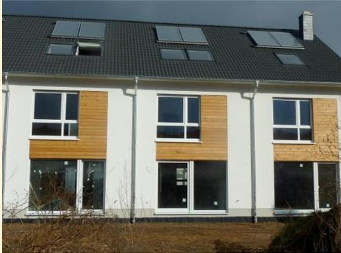
**Weiß**e Kunststofffenster in den Fassaden, unabhängig von der Größe mit eingelegten **Stahlprofilen** verstärkt und im EG mit Beschlägen nach WK 1 ausgestattet.
