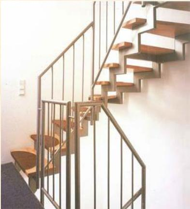
**Die** Innentreppe besteht aus einer grundierten Stahlkonstruktion mit aufgelegten Stufen in Buche, massiv, Parkett stabverleimt und hierzu passenden Handläufen.
